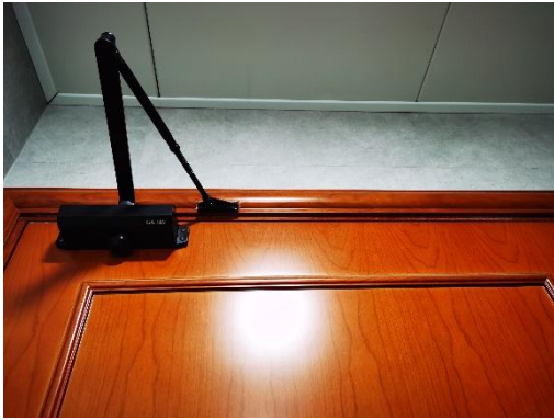
洗手间安装门吸
