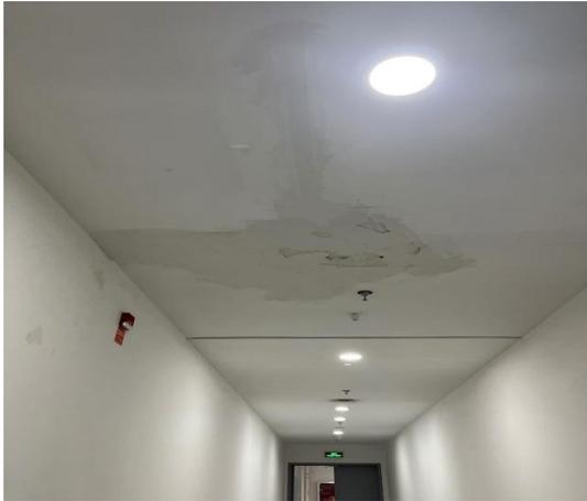
图书馆五楼漏水（维修前）
